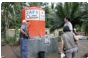
緊急支援 ① JAFSにより設置された給水施設を視察するスタッフと外部専門家 ©JPF
